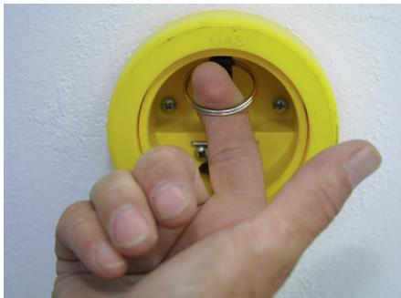
3. Mit dem Zeigefinger den Metallring greifen und ...
