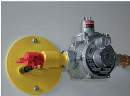
5. Über den verlegten Bowdenzug wird die Hauptabsperreinrichtung im Keller geschlossen und die Erdgaszufuhr ist unterbrochen (im Bild Hauptabsperreinrichtung vor der Auslösung).
